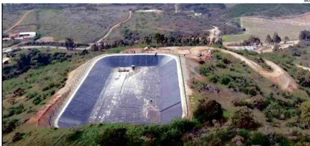
EL SISTEMA AVANZA EN SU CONSTRUCCIÓN.
