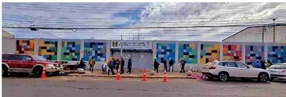
UNA VISTA PANORÁMICA DE LA NUEVA FACHADA DE LA EISA.
