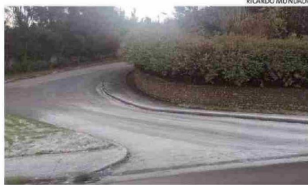
AYER NO SE DERRITIÓ LA ESCARCHA EN LAS CERCANÍAS DEL HOTEL PATAGONIA INSULAR, EN QUELLÓN.
