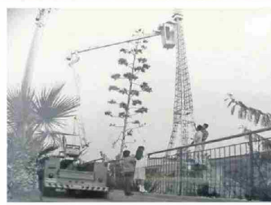
Reparación en el entorno de la Escuela Francia. (23/06/86).
