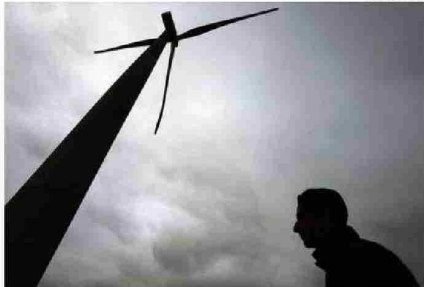
2 SON LOS AEROGENERADORES CONTEMPLADOS EN EL PROYECTO.
