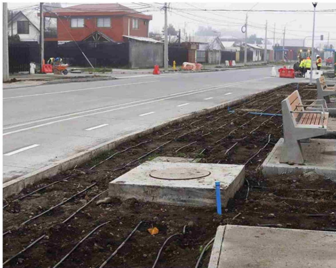
Finalizan trabajos en veredas y resaltos
