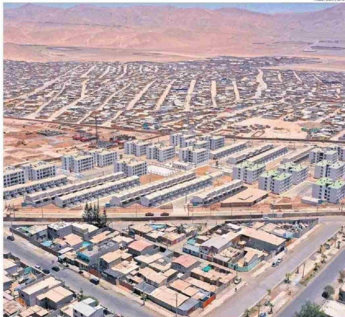
UNA DE LAS PREOCUPACIONES, ES QUE MUCHAS DE LAS VIVIENDAS NO CUENTAN CON URBANIZACIÓN.
