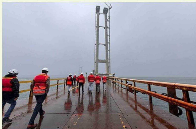
Los gobernadores realizaron una visita en terreno al puente Chacao, emblemático proyecto de conectividad que unirá la isla de Chiloé con el continente
