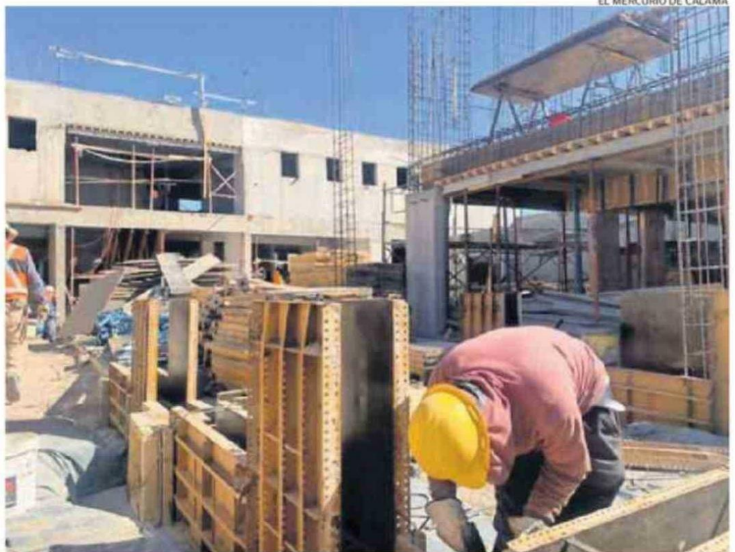
OBRA CIVILES DE LA REPOSICIÓN DEL HOGAR DE CRISTO DE CALAMA PODRÍAN ESTAR COMPLETAS EN JULIO.
