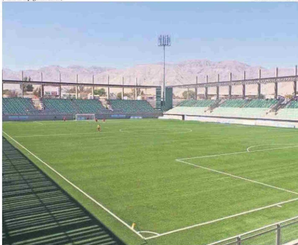
LAS LUMINARIAS NO ESTABAN ACORDE A LA NORMATIVA.
