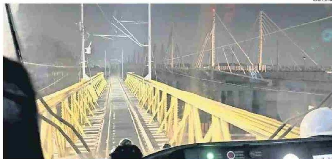
EL CRUCE POR ÚLTIMA VEZ POR EL VIEJO VIADUCTO SOBRE EL RÍO, CON EL NUEVO PUENTE A UN COSTADO.
