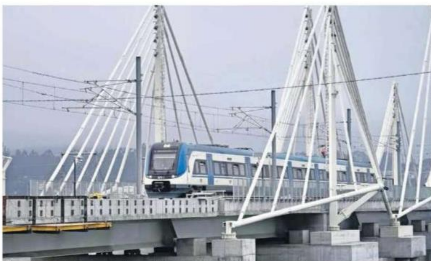
Sólo una de las vías del nuevo puente está disponible para la circulación de trenes de pasajeros y de carga.
