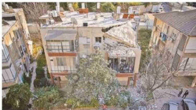
Los oficiales del Comando del Frente Interior de Israel inspeccionan un edificio de apartamentos dañado después de un ataque con misiles iraníes.
