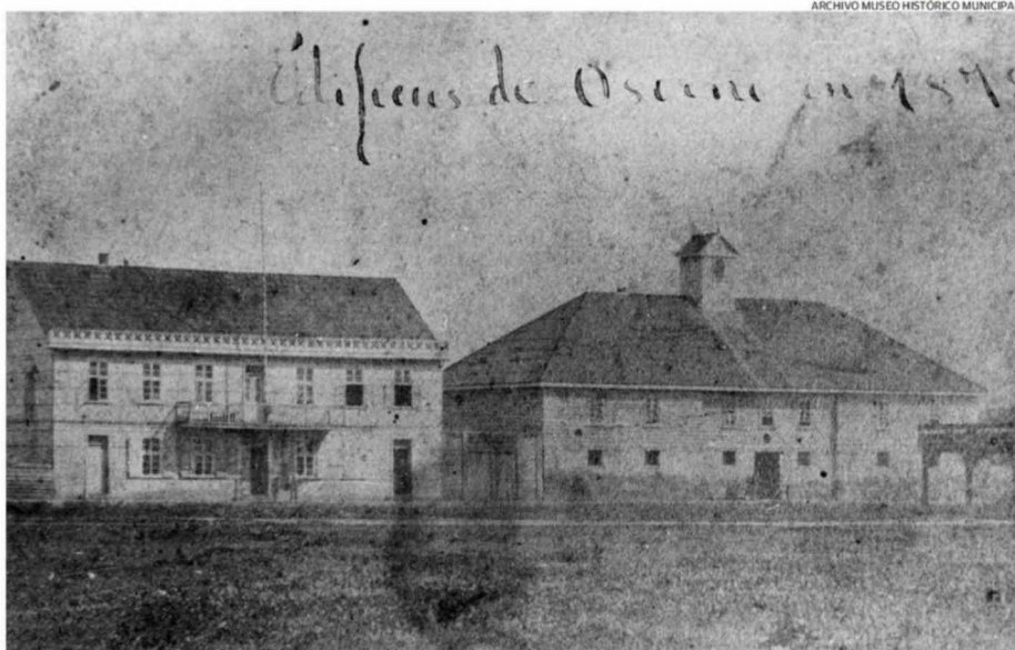
EL EDIFICIO QUE ESTÁ A LA DERECHA FUE CONSTRUIDO POR JUAN MACKENNA PARA EL CABILDO Y LA CÁRCEL DE OSORNO. LA IMAGEN ES DE 1878.
