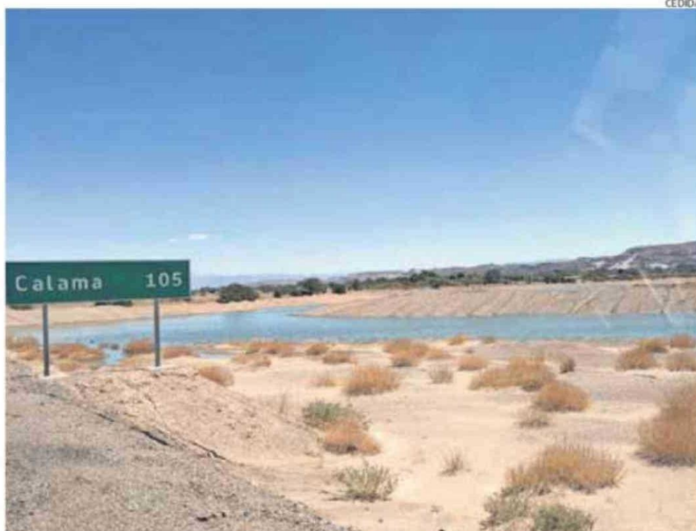
LAS FILTRACIONES SE PRODUJERON EN UN SECTOR CERCANO AL BY PASS CON LA RUTA 23CH.
