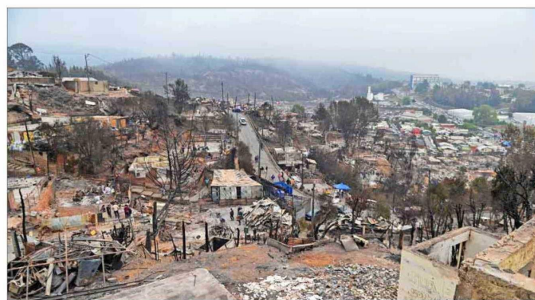
CATÁSTROFE. — La localidad fue una de las más afectadas por los incendios, con gran parte de las residencias que la componen destruidas.
