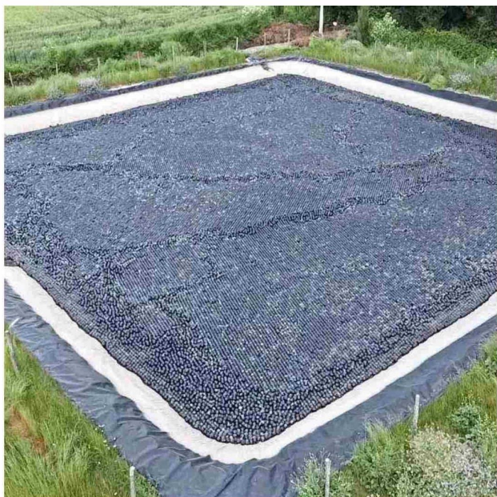
Las Barrier Balls son esferas flotantes que reducen la evaporación del agua mejorando así el riego y la eficiencia hídrica.
