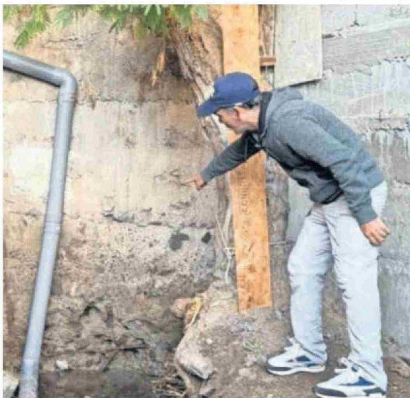
DESDE LA SANITARIA ASEGURAN QUE AÚN BUSCAN EL ORIGEN DE LAS FILTRACIONES EN LA ZONA.
