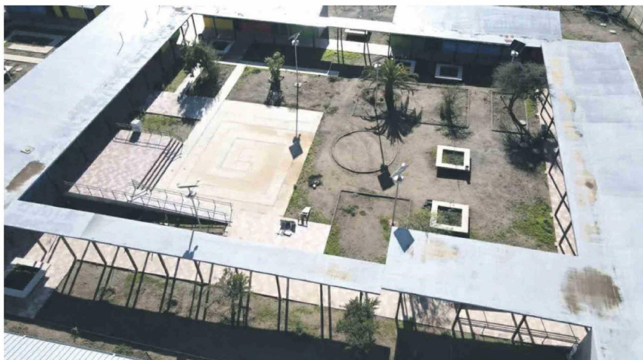
La comunidad educativa de Barraza aún espera la apertura del nuevo recinto escolar, cuyas obras se encuentran en su etapa final.
