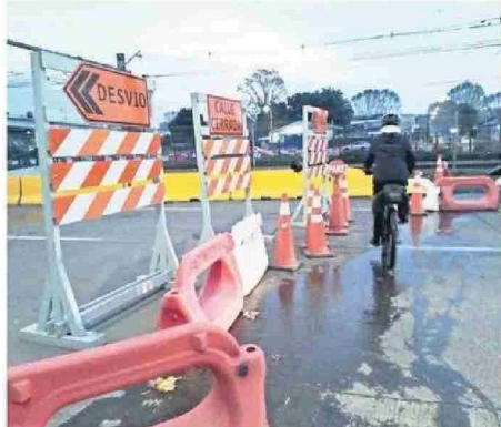
DESVÍO EN CALLE PADRE HURTADO POR LAS OBRAS.
