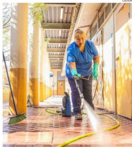
LOS TRABAJOS SE REALIZAN PREVIO AL RETORNO DE LAS CLASES.
