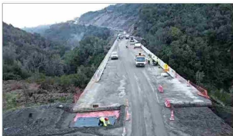
A 60 metros de altura, sobre una quebrada en el río Gamboa, retomaron la construcción de este viaducto que se estaba deteriorando.
