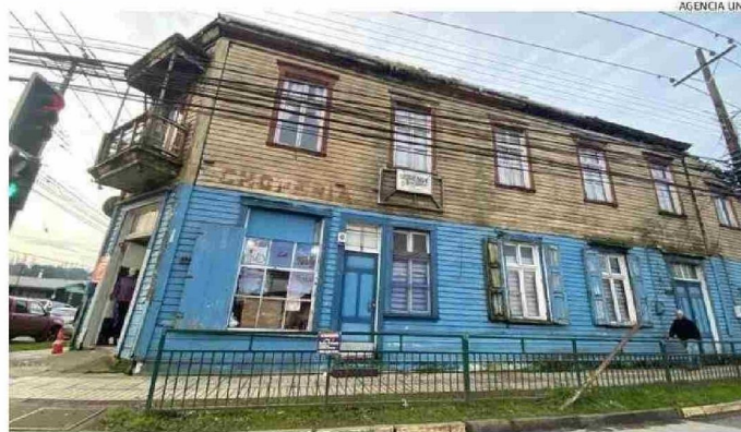
EN CALLE LOS CARRERA HAY NUMEROSOS INMUEBLES ANTIGUOS, VETUSTOS Y VISIBLEMENTE DETERIORADOS.
