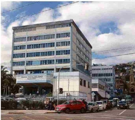
EL RECINTO REQUIERE URGENTEMENTE DE UNA AMPLIACIÓN.
