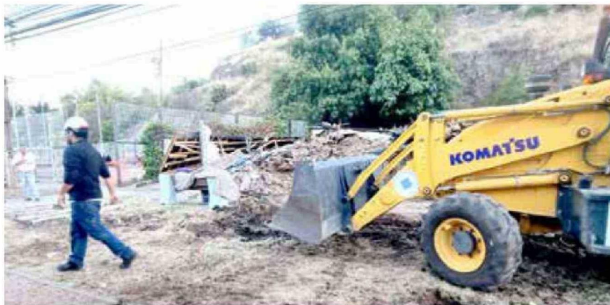
El propio alcalde de Curicó, George Bordachar, firmó el decreto, que permitió el desarrollo de la demolición.
