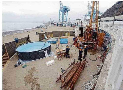
TRABAJOS SE REALIZAN A UN COSTADO DE LA AVENIDA ALTAMIRANO.
