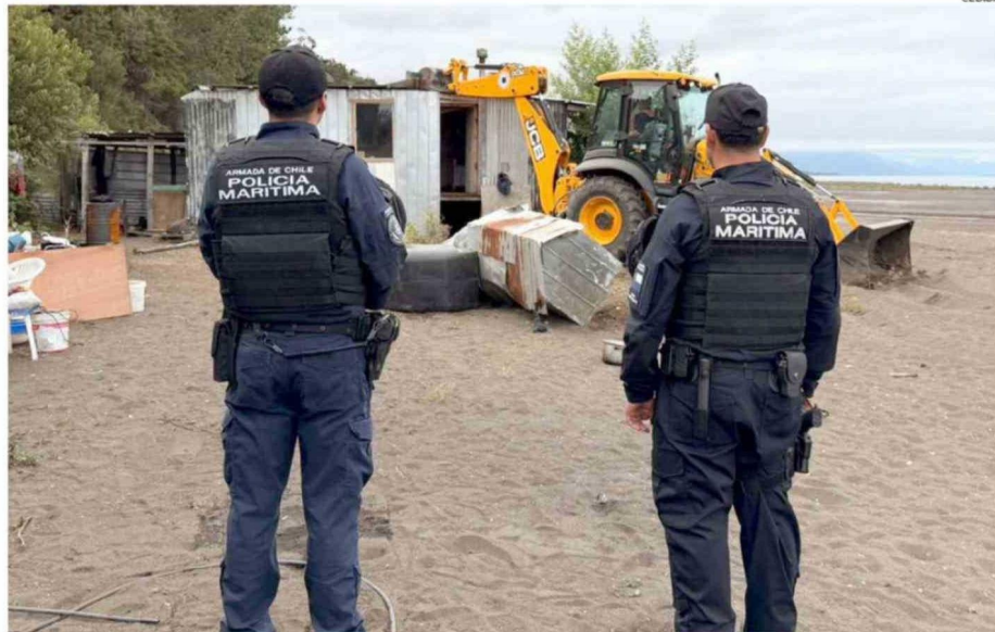
UNA RETROEXCAVADORA FUE UTILIZADA PARA DESARMAR UNA DE ESTAS VIVIENDAS.
