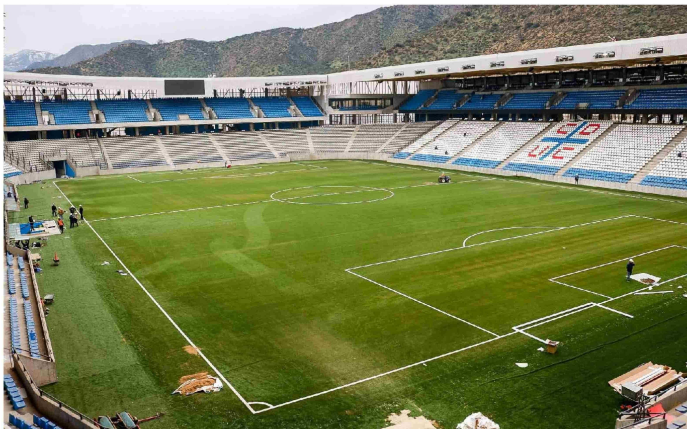
► Este lunes, llegó a San Carlos de Apoquindo el visto bueno de la Dirección de Obras Municipales de Las Condes.
