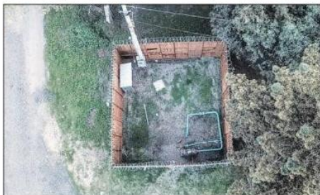
La toma del pozo 9 activó una serie de acciones que hoy permiten tener agua en el sistema. Sin embargo, la red sigue siendo muy precaria y, si no se mejora, el agua podría volver a faltar o depender de voluntades particulares.
