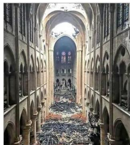
13 millones de turistas al año recorrían la nave central de Notre Dame (aquí un día después del incendio).
